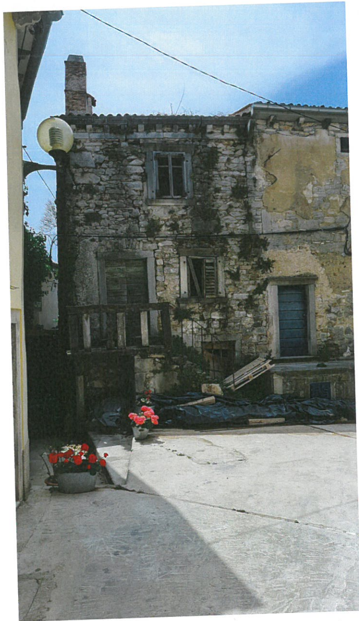
k.č.280 k.o. Labin-Presika zgrada –ruševina sjeverni dio
