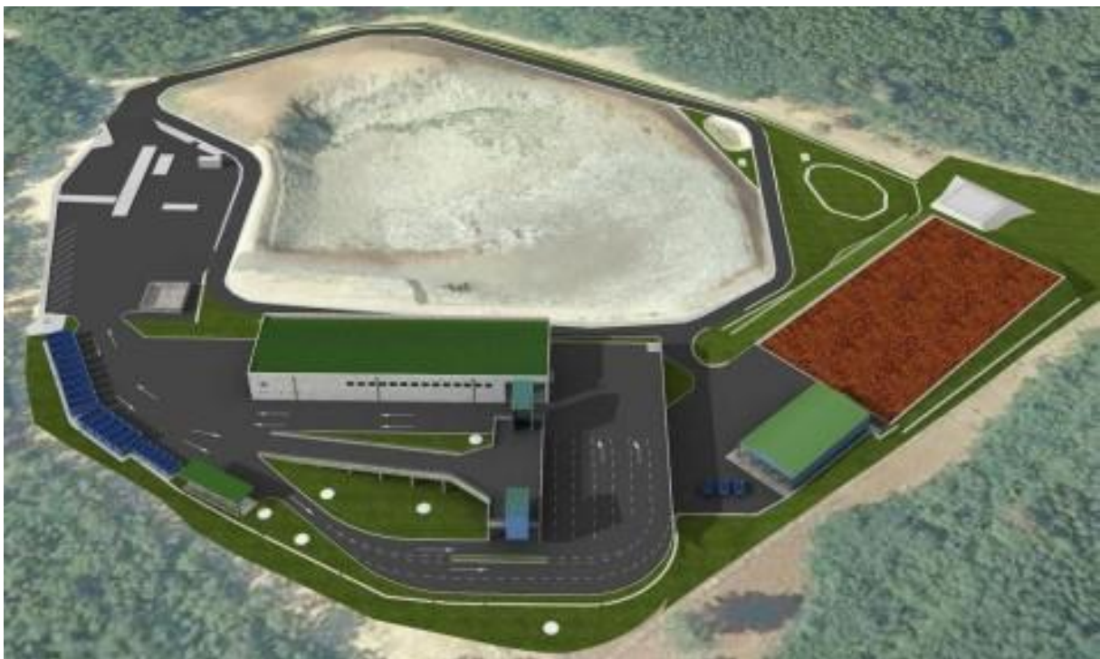
Kompletni prikaz zamišljene sanacije komunalnog odlagališta Cere, gdje se vide tijelo deponija, pretovarna stanica, sortirnica, reciklažno dvorište i kompostana.
